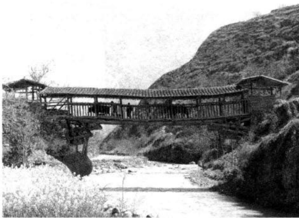
白马河上的廊桥
