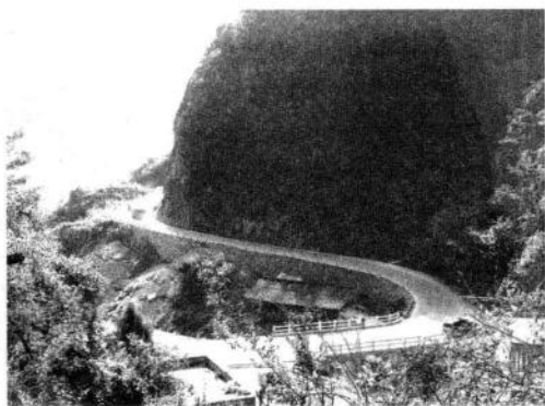
升等改造后的 212 国道
