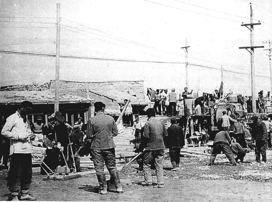
黄河路修建中
