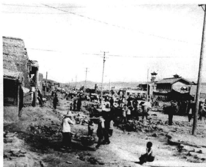
改建中的东大街 (远处可见清真大 寺唤醒楼)
