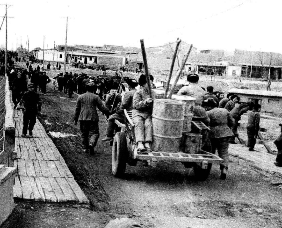
修建中的莫家路桥
