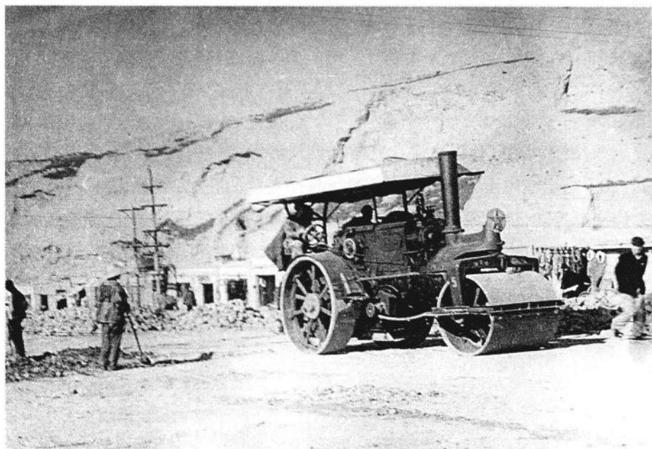
城墙下长江路正在修建中
