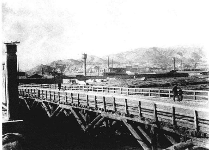
西宁城东丰骑沟桥
