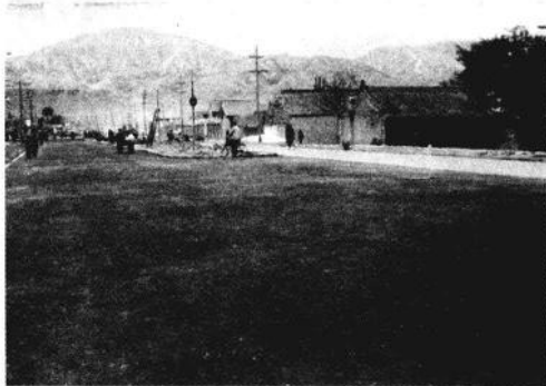
黄河路路面铺设完成
