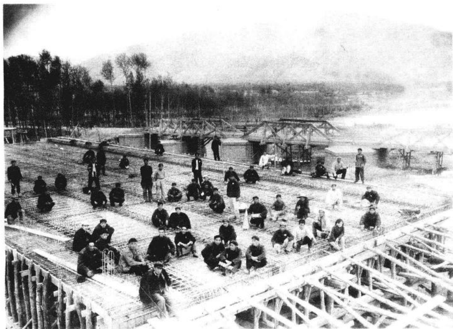
修建中的新宁桥(桥北侧可见上世纪 30 年代西路军战士参与修建的惠宁桥)
