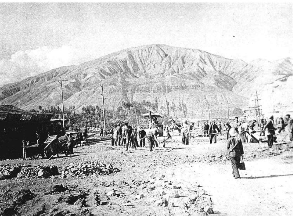
修建中的长江路(照片右侧可见尚未拆毁的回城墙)
