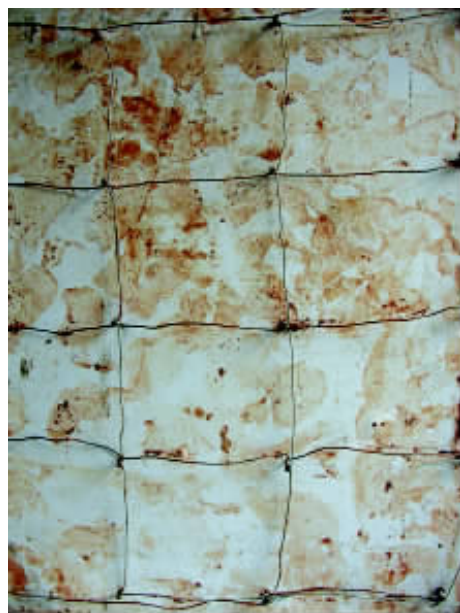
图3-11-1 在浮雕板的钉子上扣铁丝
