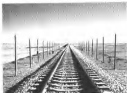
图2 热棒试验路基
