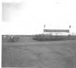
灌注施工现场
