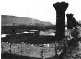
图1 开心岭2 # 桥防护围栏
