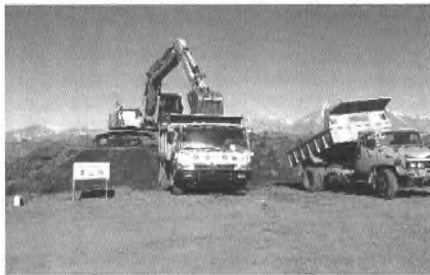
取土场分区开挖
