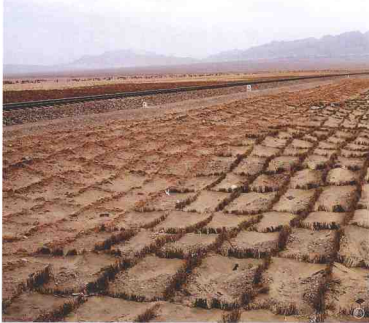
草方格防治沙化保护铁路
