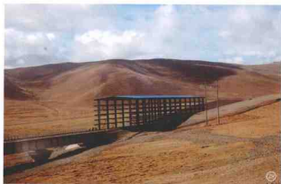
唐古拉山附近采用遮阳棚技术保护多年冻土路基
