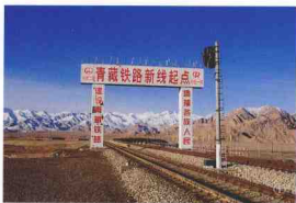
青藏铁路格拉段南山口起点
