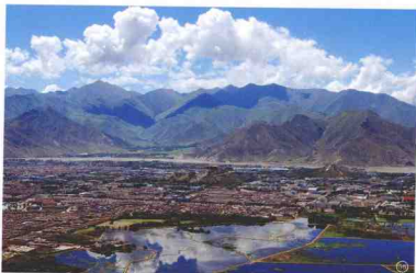
建设中的拉萨市
