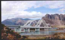
拉萨河铁路桥
