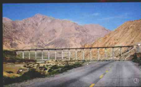
青藏铁路第一高桥——三岔河大桥
