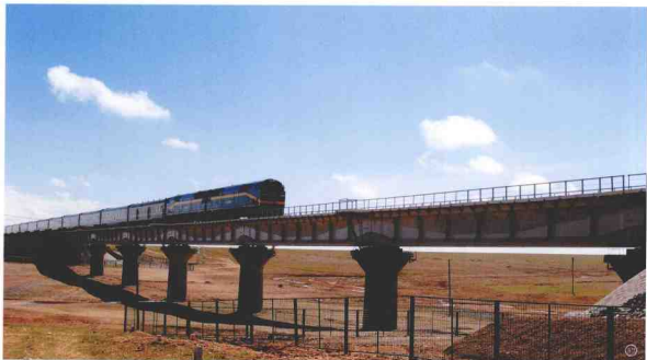
列车通过五道梁区段桥梁式动物通道
