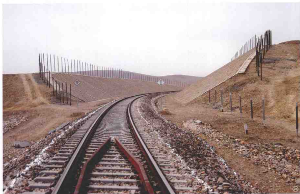
青藏铁路昆仑山口至五道梁段采用通风管技术保护多年冻土路基
