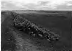
图1 片石保温护坡
