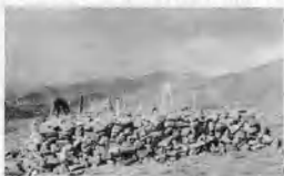
图3 青海热水块石路堤试验(1973年)
