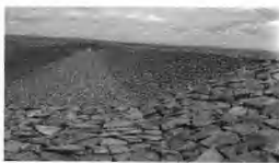
图 4 北麓河坡碎石护坡试验 (碎石直径: 5~8 cm 和 40~50 cm)
