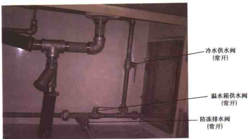
图 10.10 洗盆下部管路结构
