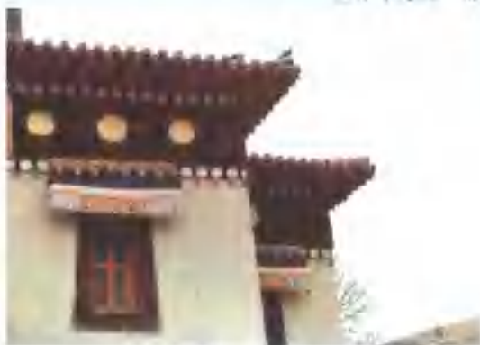
千都寺大殿堂的檐廊女儿墙
