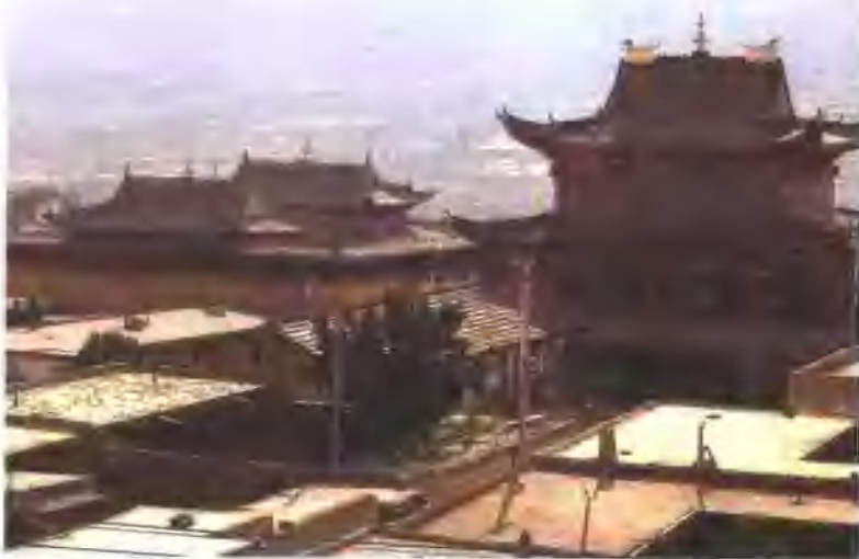
隆务寺建筑局部
