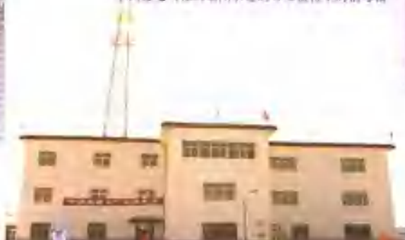
中铁建电气化局集团承建的万丈桥上信号楼
