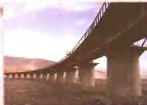
中铁十四局集团承建的青藏铁路小南川大桥。
