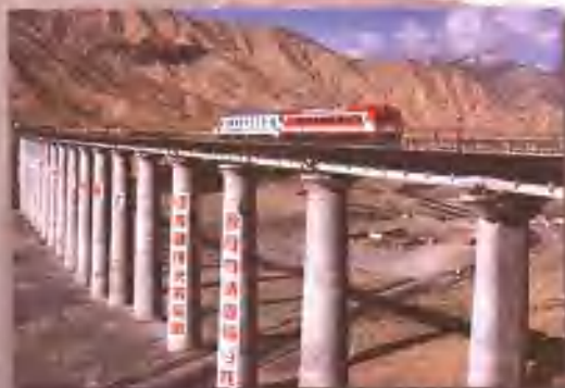
经国务院、铁道部、团中央联合授予的“国家重点工程建设青年突击队”的青藏铁路第一高桥——三岔河特大桥。
