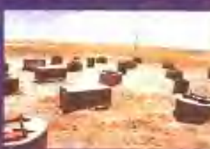
70年代冻土塔桥基试验场
