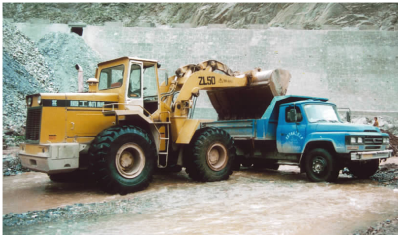
陇南地区兴修水利现场
