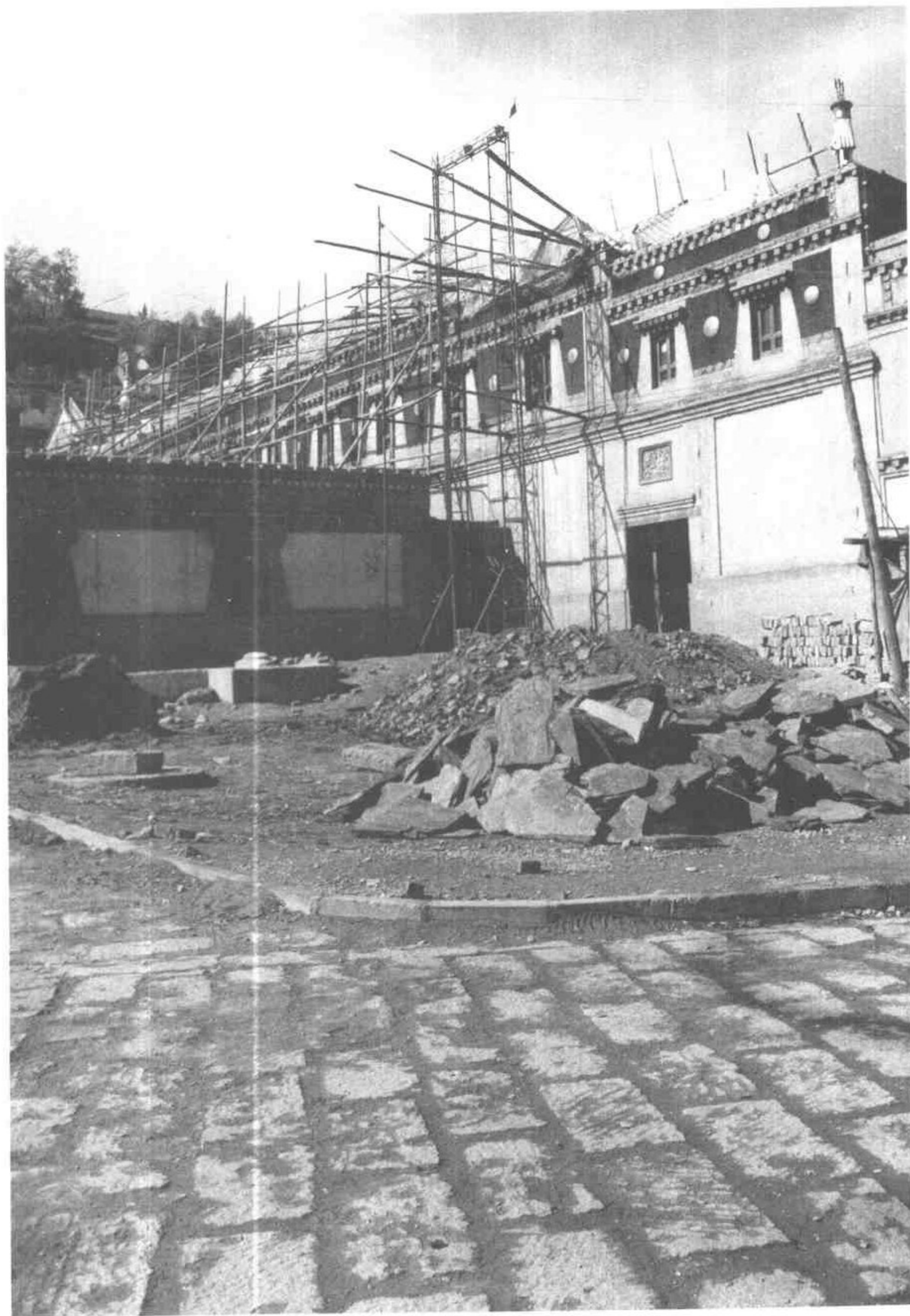
六五 維修中的大經堂南側牆壁
