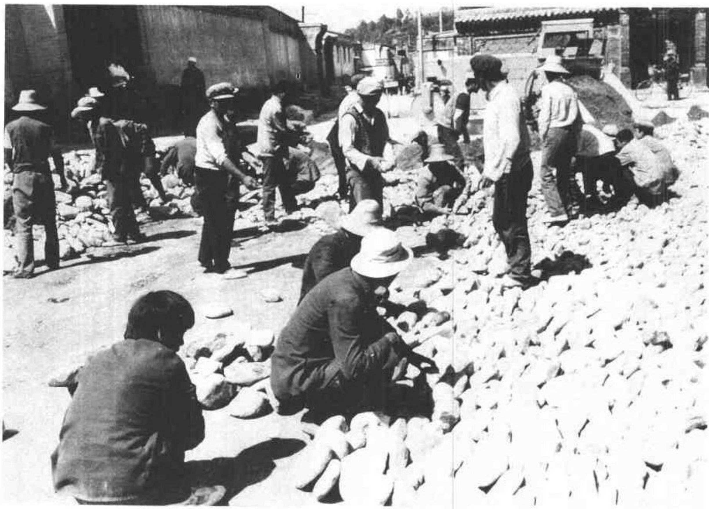
七二 維修中用塊石鋪築寺內路面的情景
