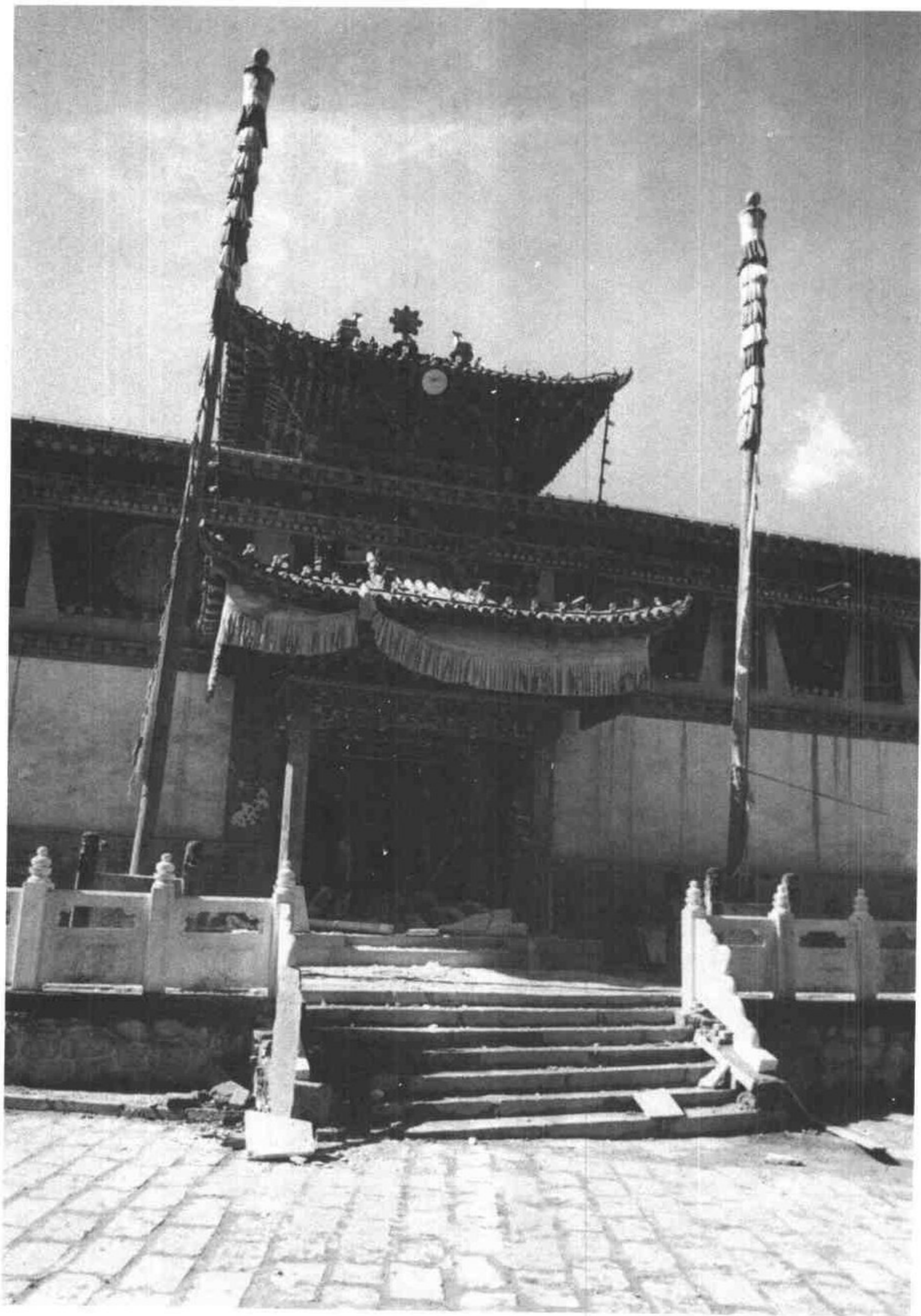
六四 維修中的大經堂前廊門樓
