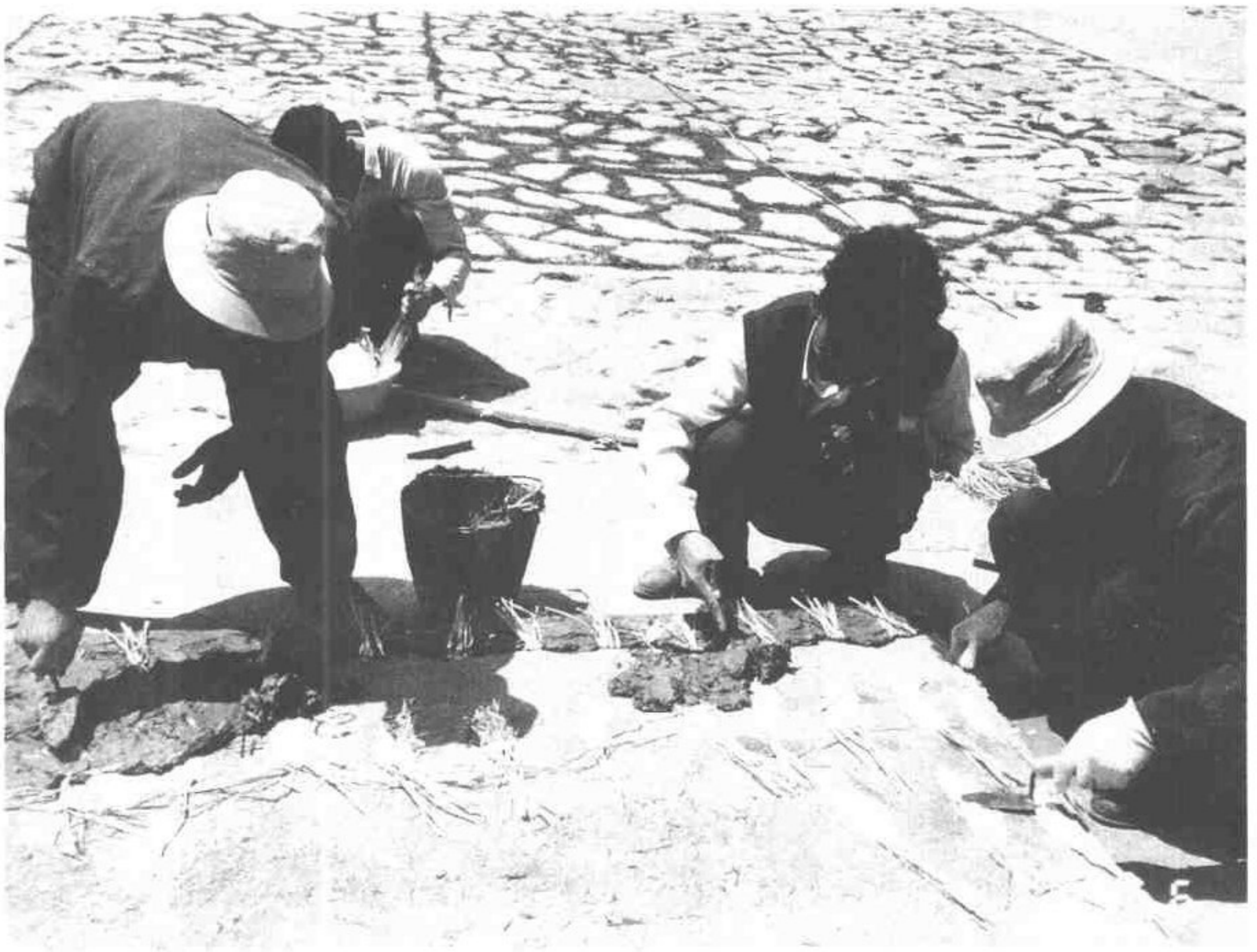
五九 維修中將彌勒佛殿壁畫卸下後進行背襯加固的情景
