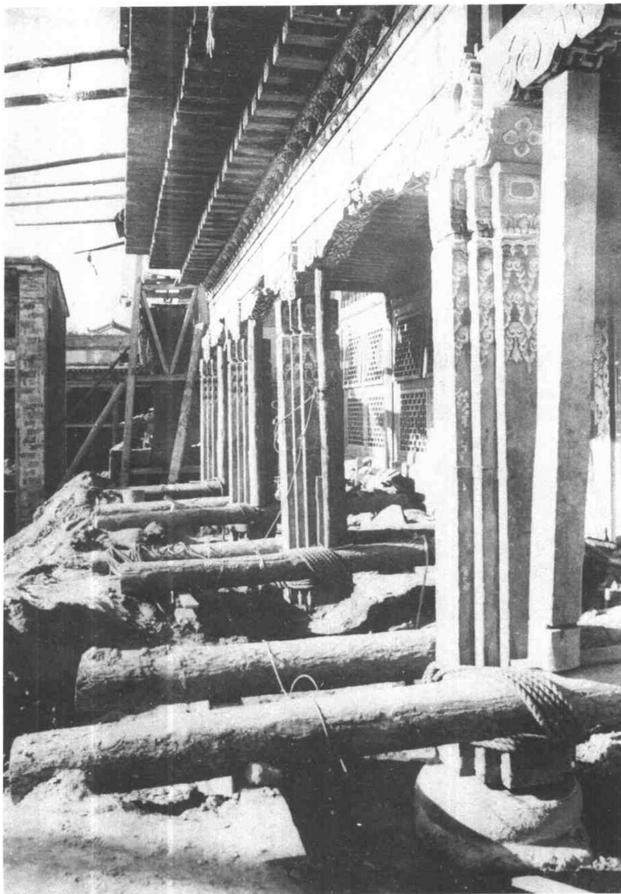
五一 維修中將達賴、班禪行宮大佛堂東廊的柱子擡起後進行基礎處理的情景
