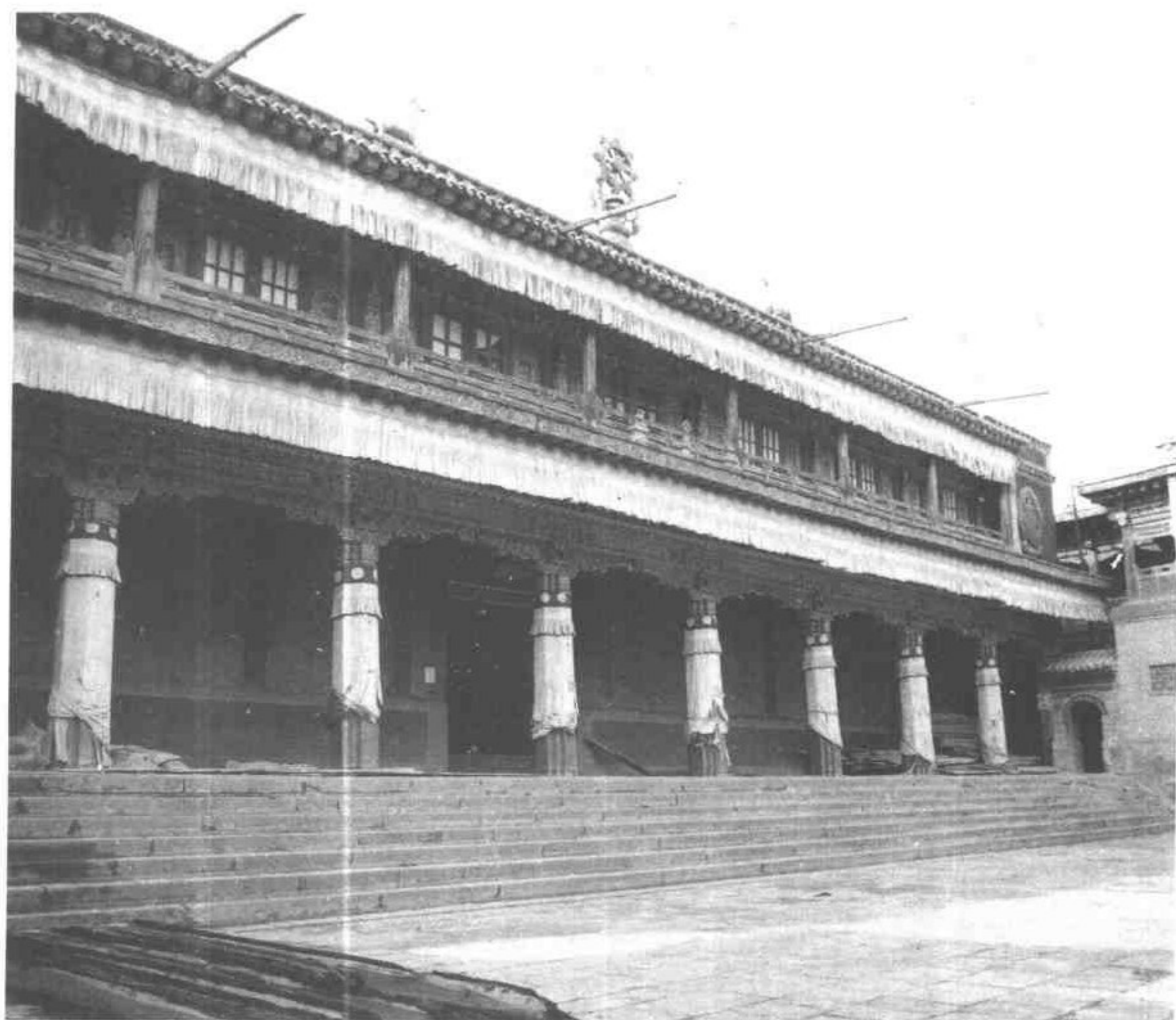
六七 維修中的大經堂正殿外景
