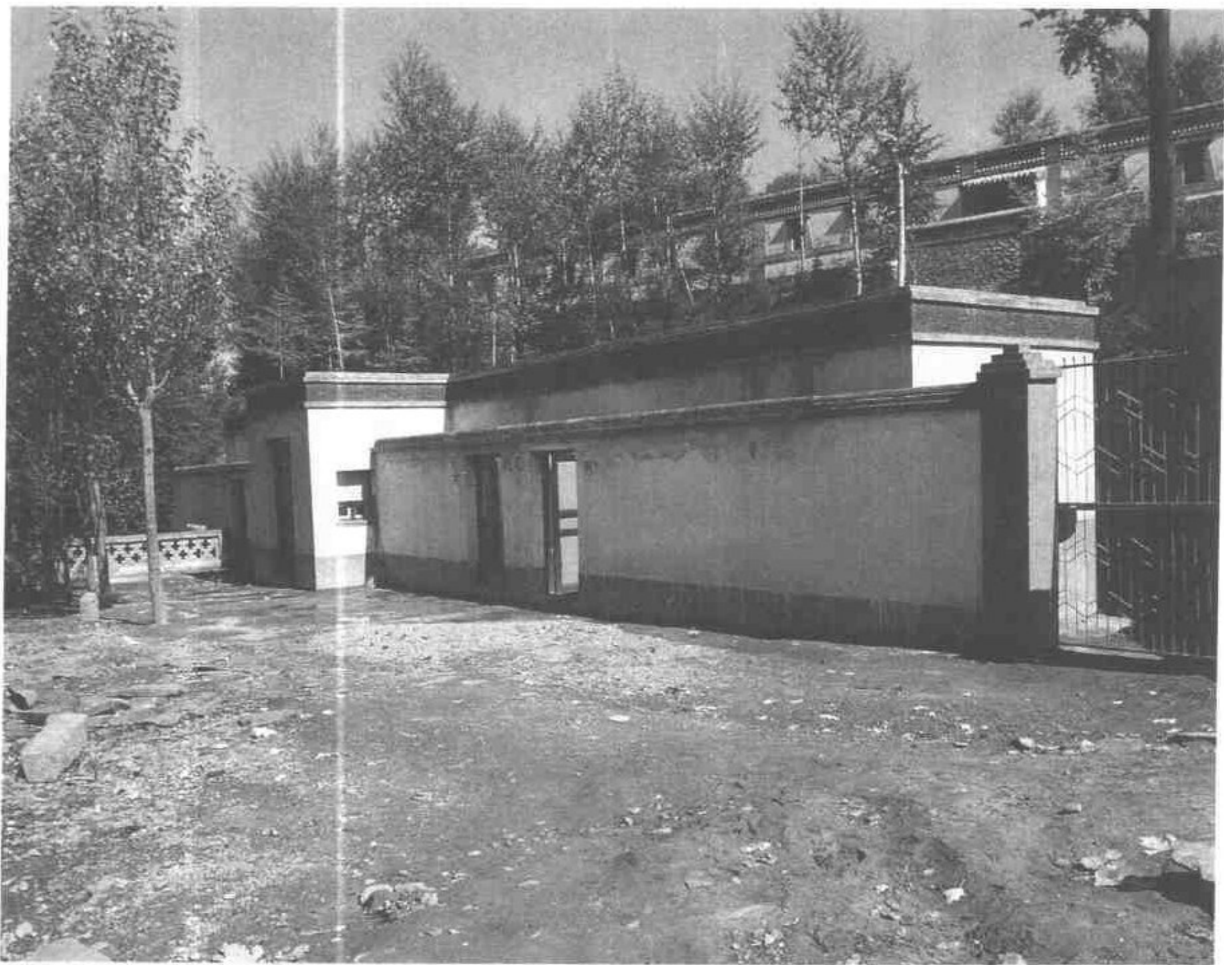
七七 維修中新建的公用廁所
