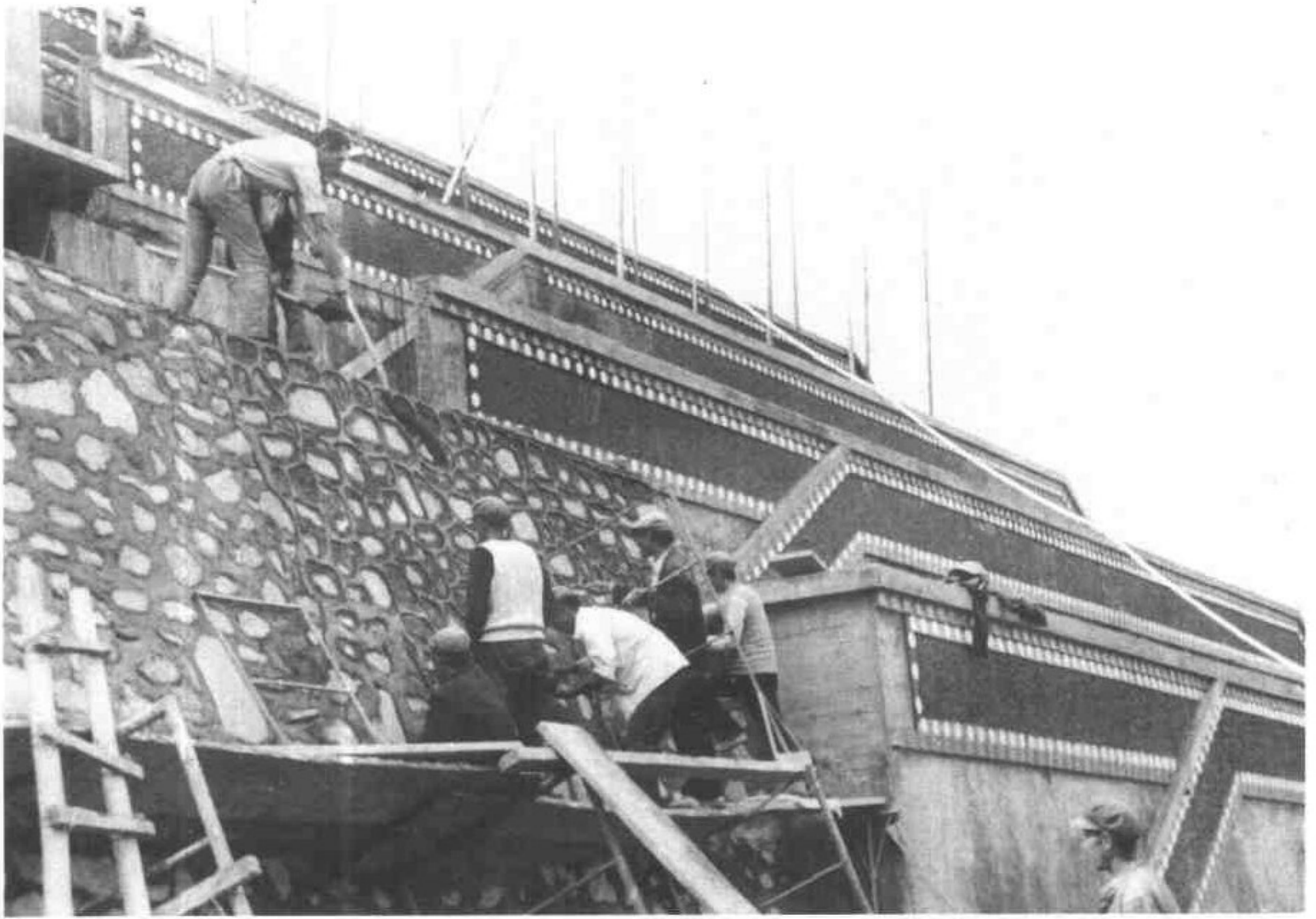
四九 維修中新砌的達賴、班禪行宮前坡的擋土牆
