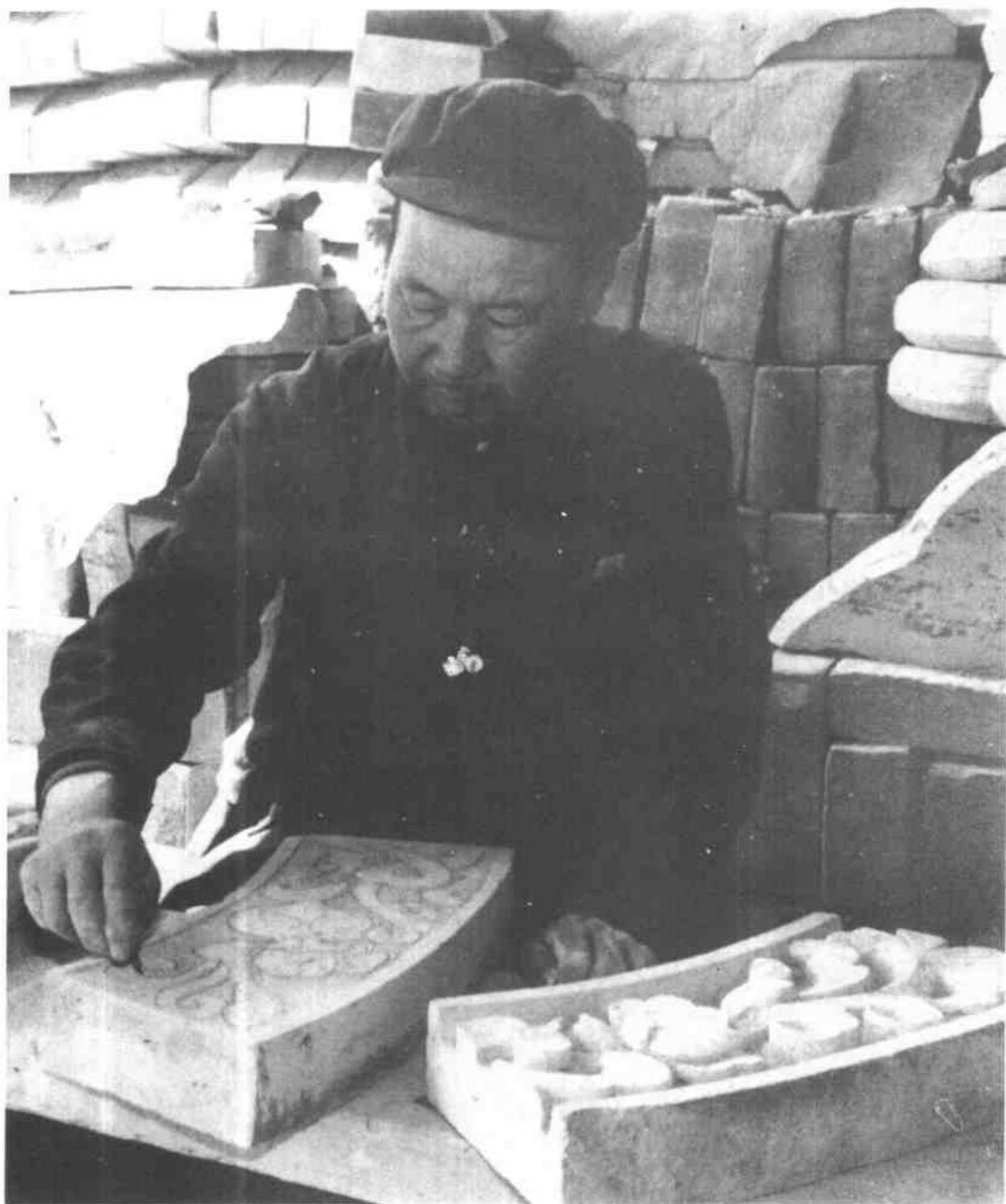
三五 維修中老石匠精心進行磚雕的情景
