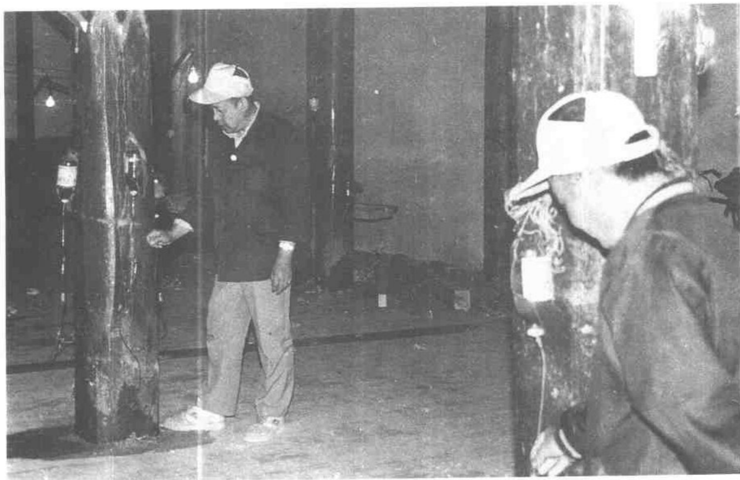
五二 維修中對達賴、班禪行宮的木構件進行防腐處理的情景
