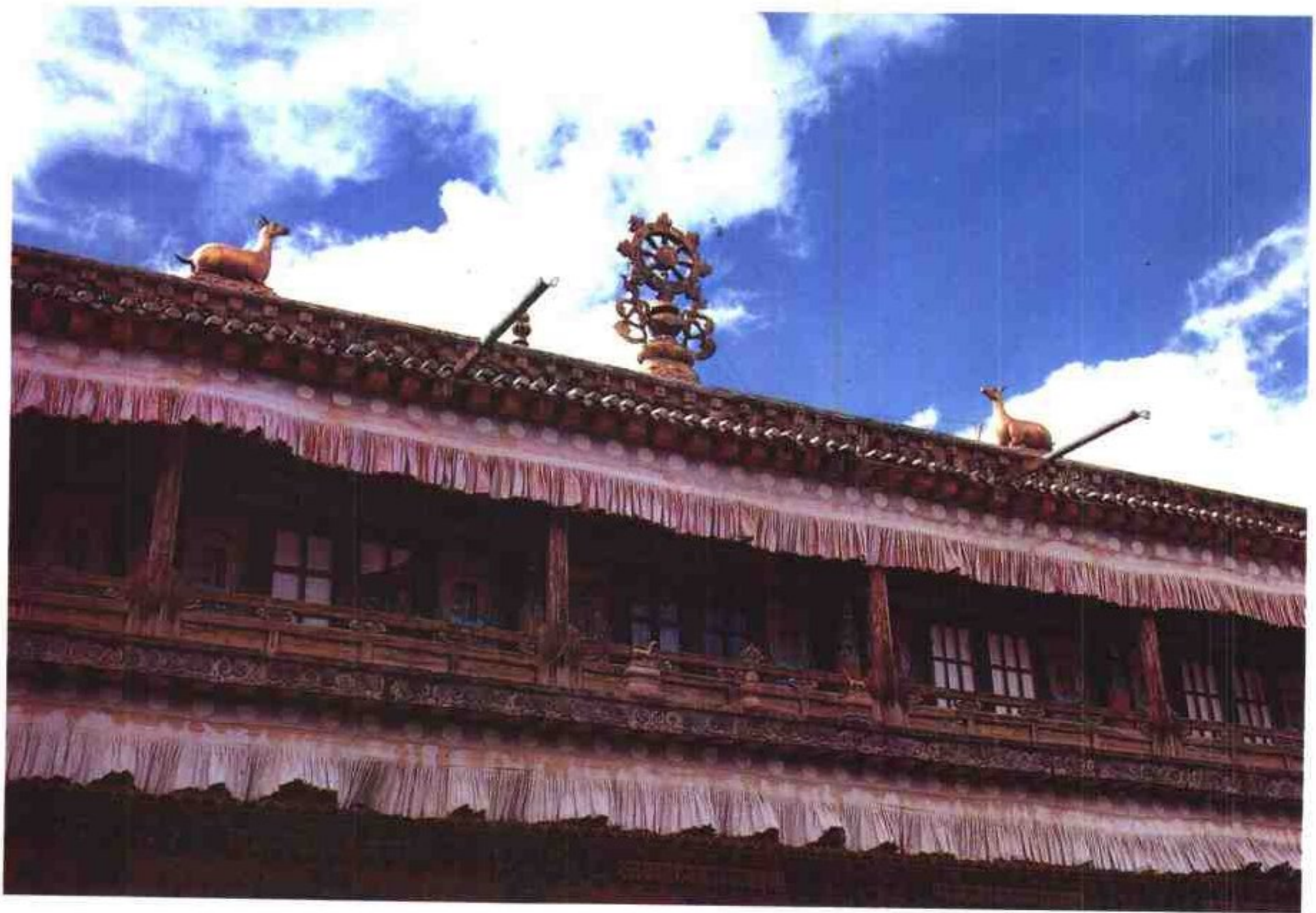
三六 維修後的大經堂正殿前檐第二層廊柱
