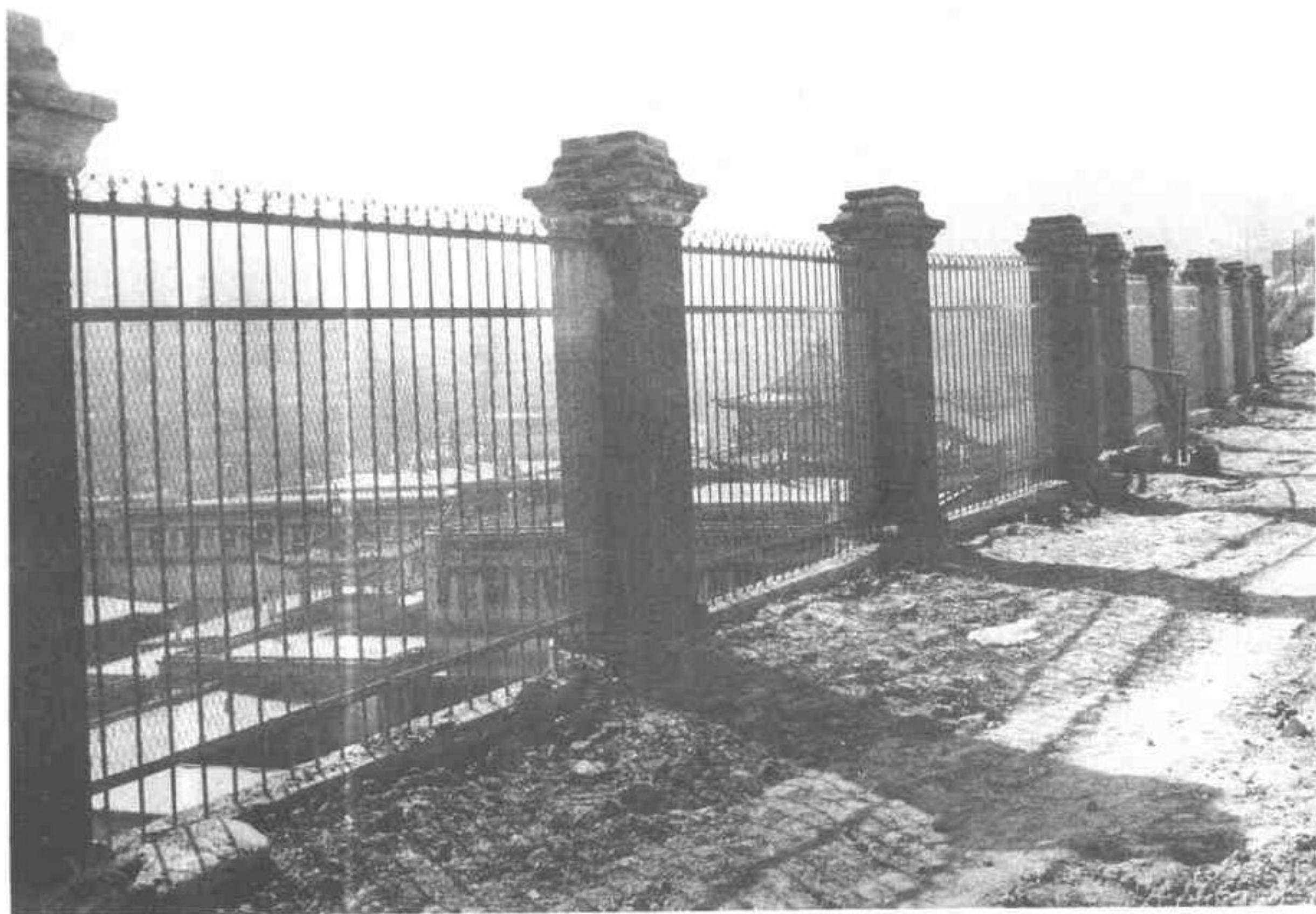
五三 維修中在達賴、班禪行宮前側新裝的護坡欄杆
