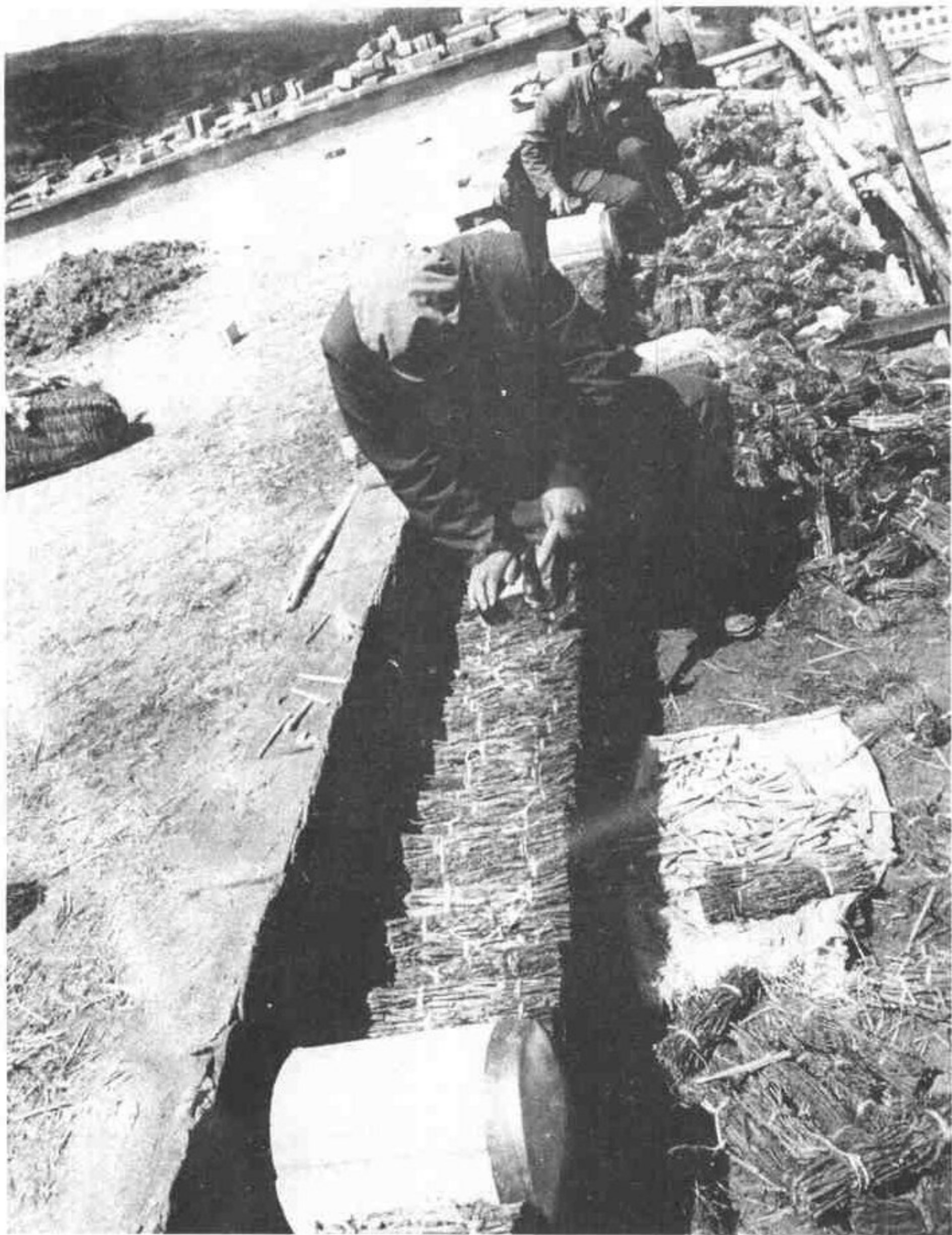
七〇 維修中用傳統工藝砌築大經堂檉柳牆的情景
