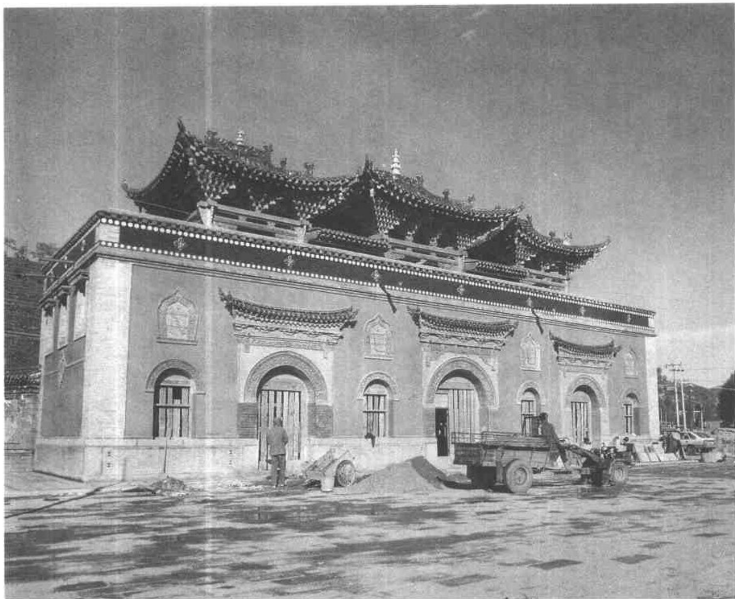
四〇 維修中正在施工的山門
