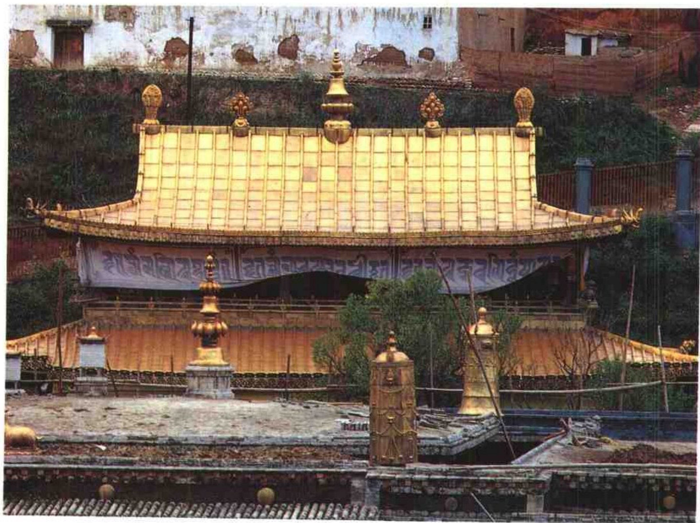
二六 維修後的大金瓦殿金頂正面
