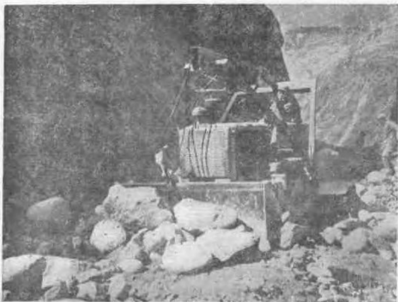
康藏公路修建中，以推土機剷除沿途卵石、塊石障礙
