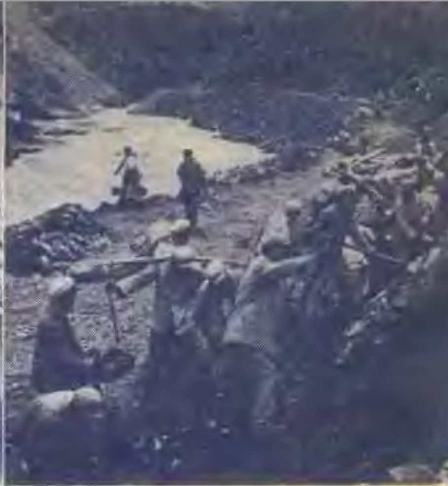
康藏公路經過許多流沙地區。圖為在流沙地區築路情形。
