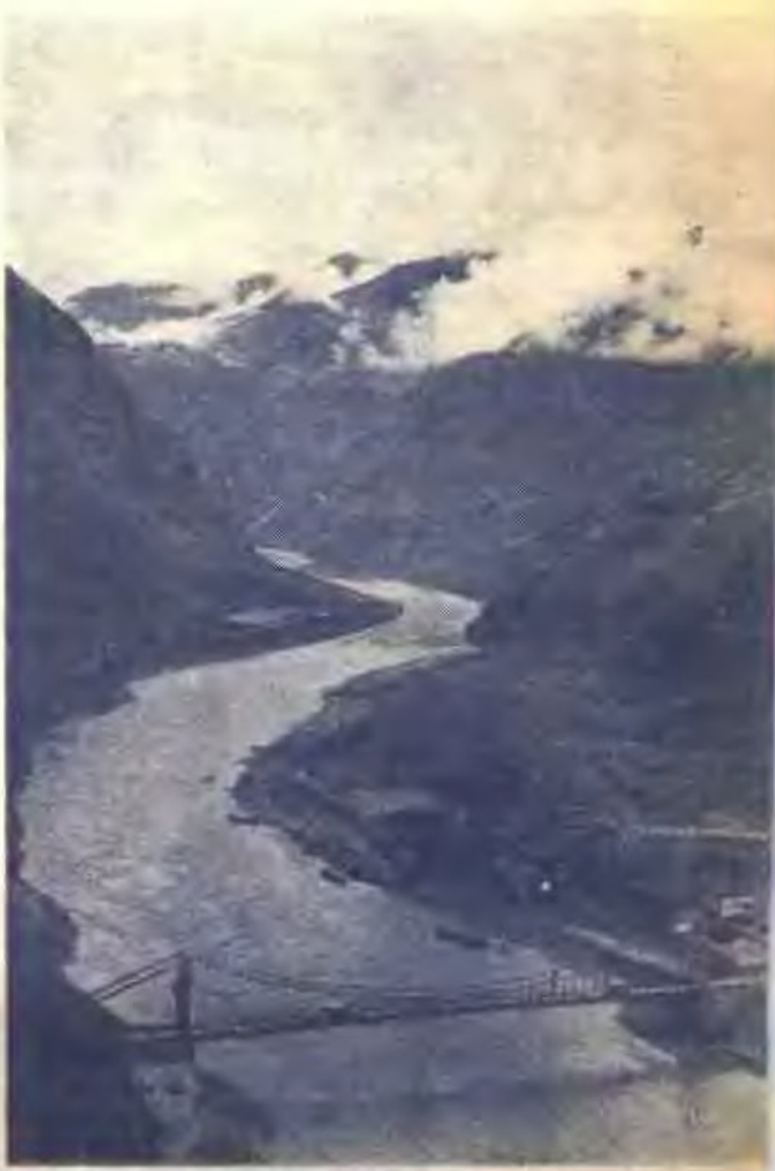
鋼索吊橋。 康藏公路通過著名的大渡河，築路英雄們在河上架起了鋼索吊橋。
