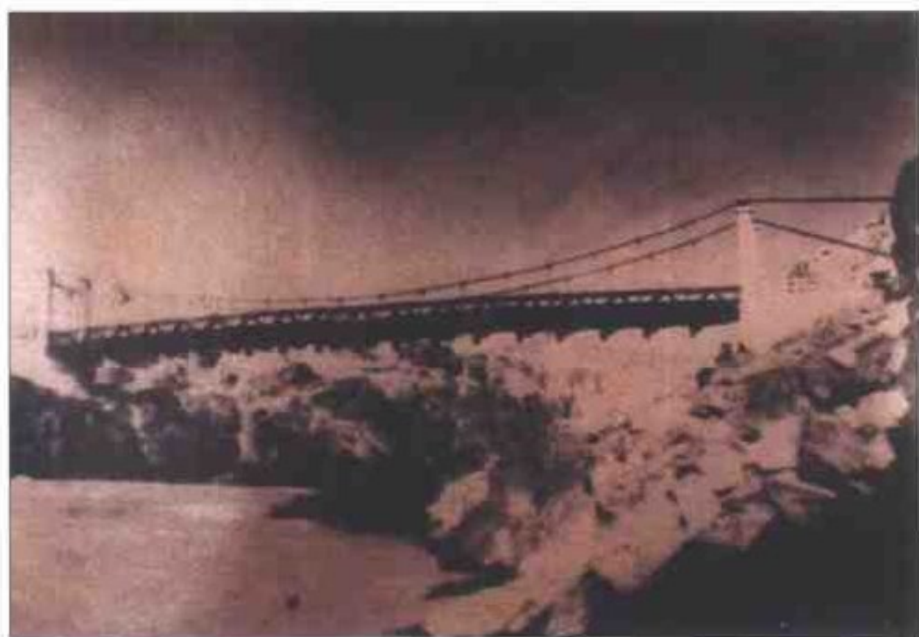
原龙羊峡黄河悬索桥
