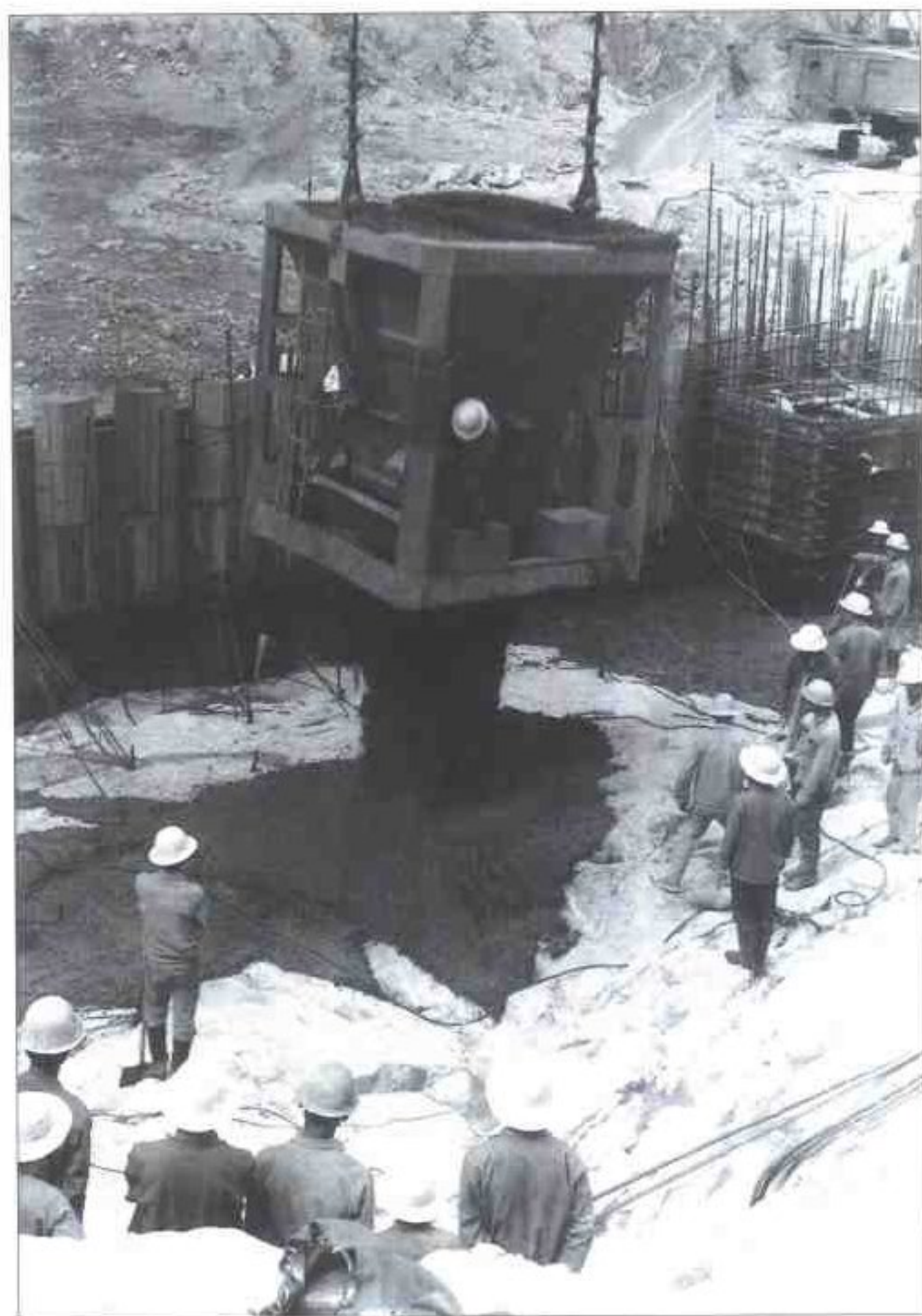
1982年6月28日，大坝第一罐混凝土开盘浇筑
