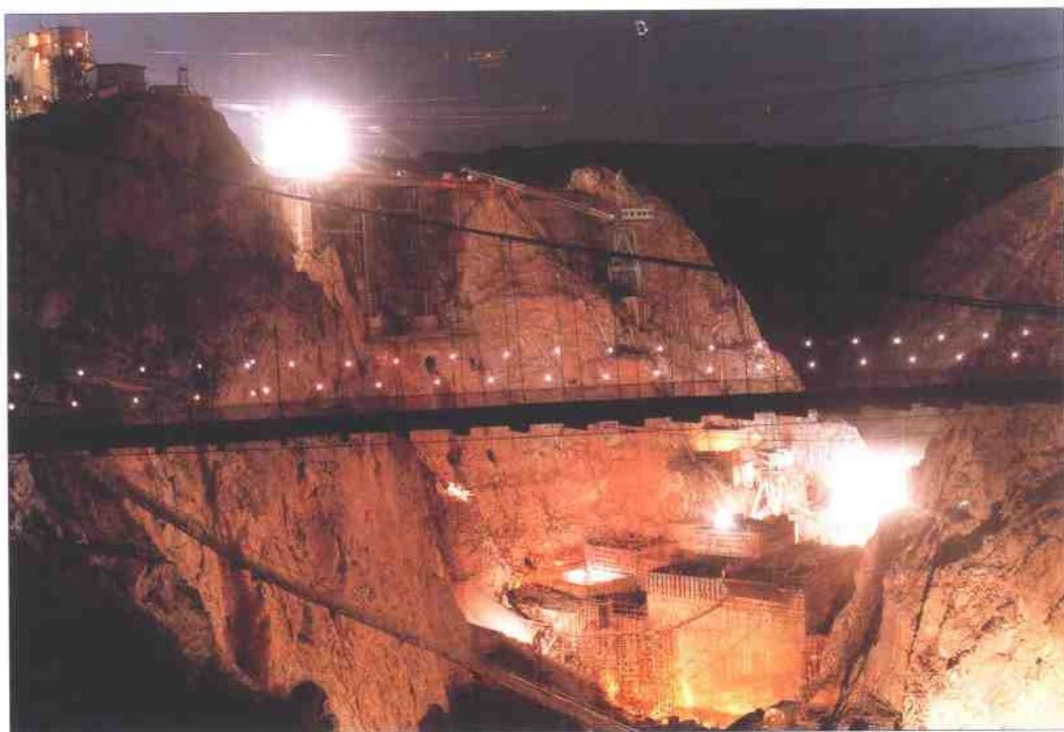
主坝初期施工夜景
