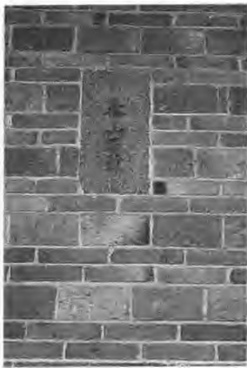
腾冲汉族民居的墙上镶嵌着刻有“太极图”和“泰山石敢当”字样的石板
