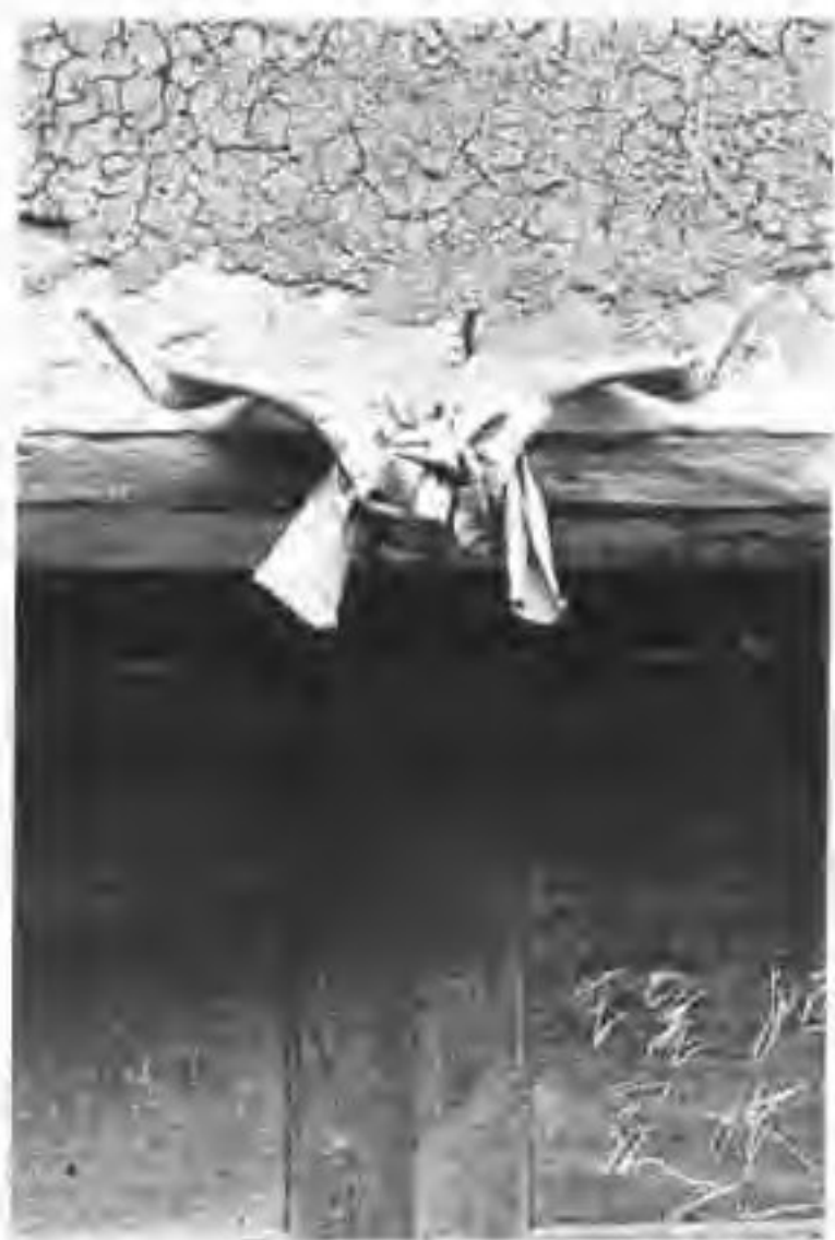
昆明郊区农村民居挂羊头压土
