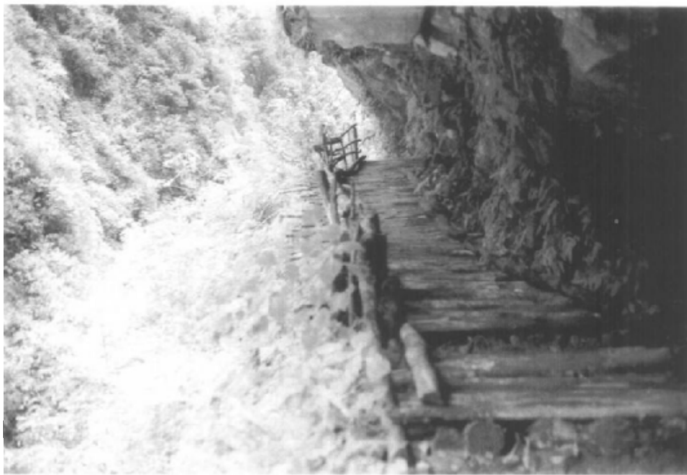
老虎嘴栈道天 险以峻险闻名。高 悬在峡谷陡壁上。
