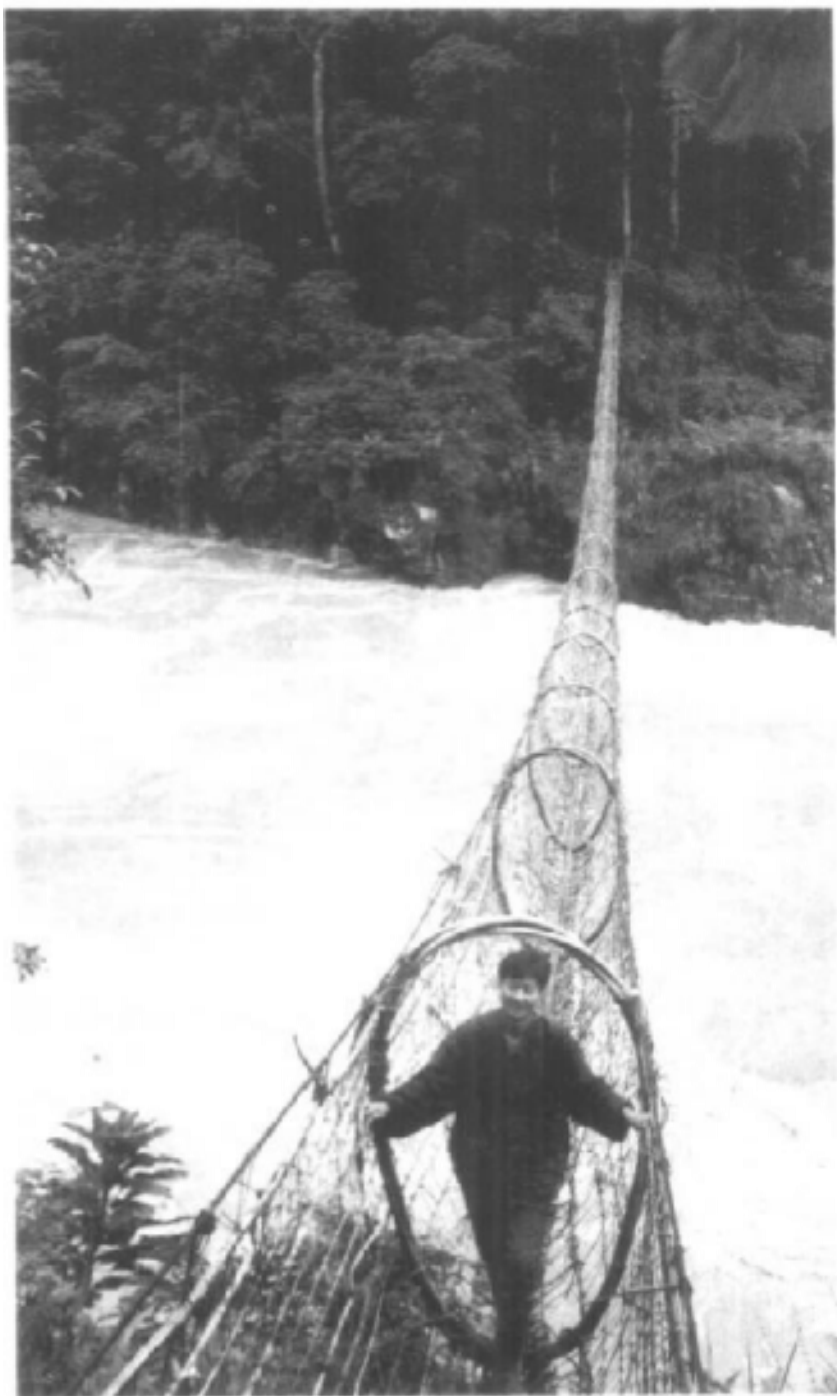
横跨在大峡谷雅 鲁藏布江激流上的 “藤环桥”。
