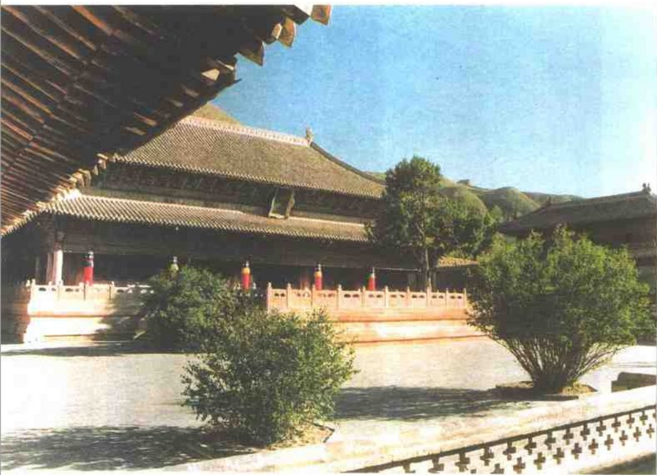
瞿昙寺隆国殿建筑侧海景 贾鸿键摄
