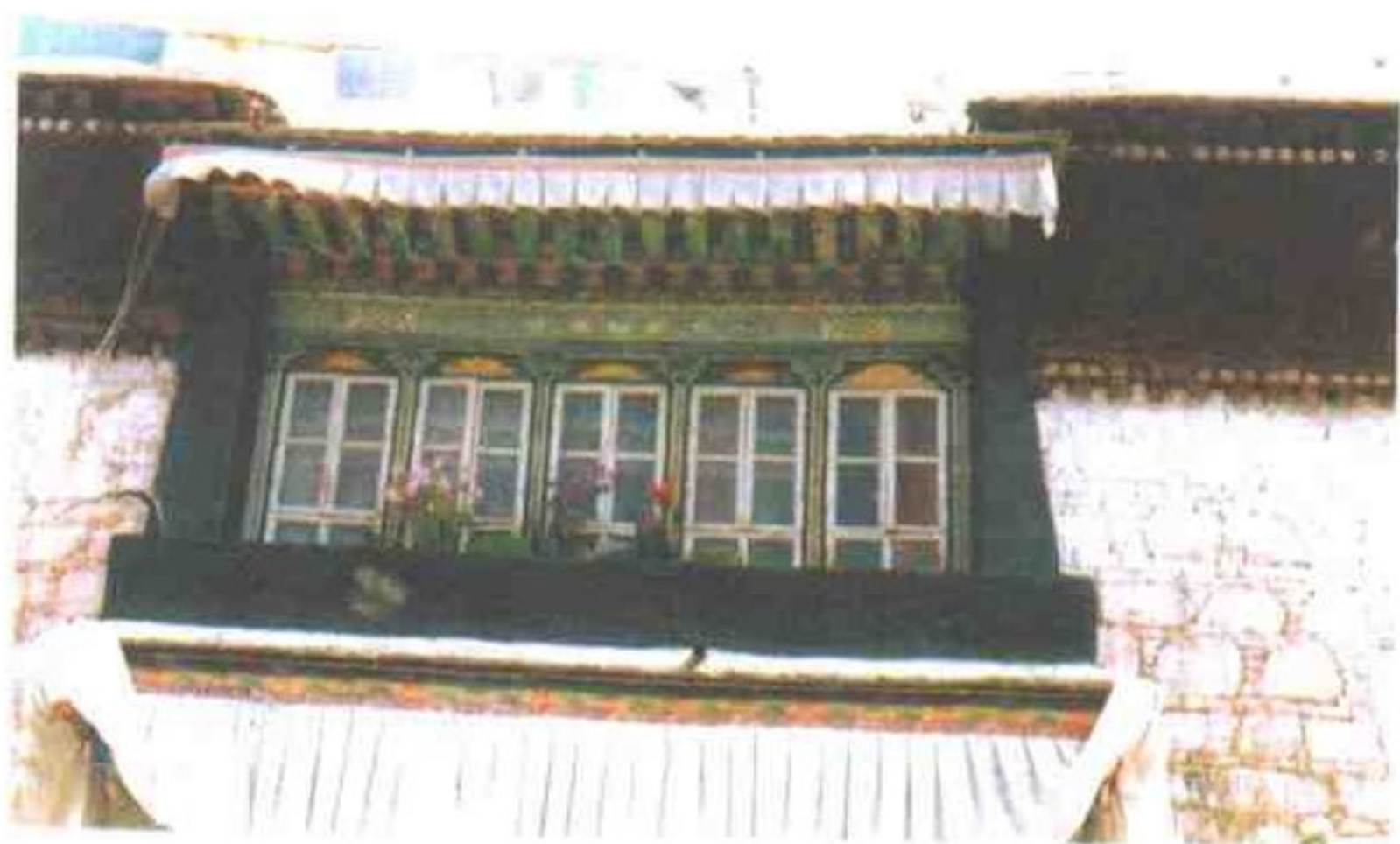
较为古老的传统藏式建筑的窗户装饰处理。窗户两侧的红墙是边玛草墙，在旧西藏边玛草墙只有寺院、政府、世袭大贵族建筑才能享有，民居建筑不能砌筑边玛草墙。 次多摄
