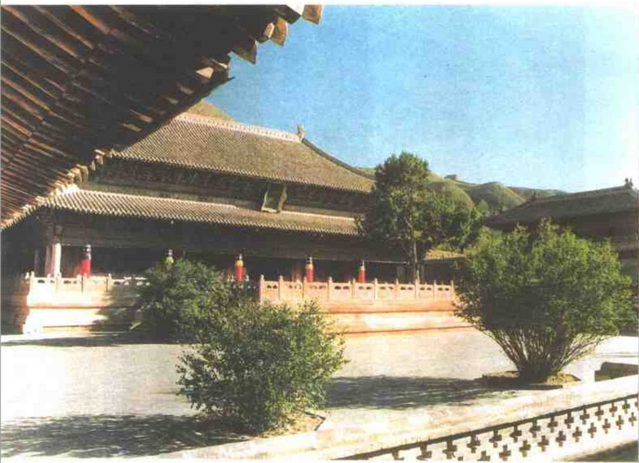
瞿昙寺隆国殿建筑侧海景 贾鸿键摄
